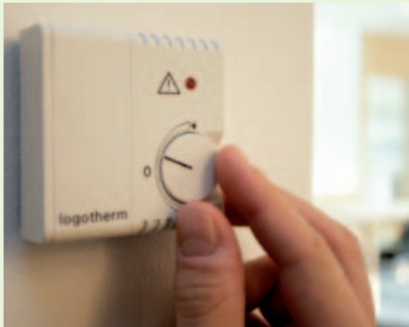
HDG Lambda-Control 2 dispune opțional de o unitate de comandă în spațiul locuit, unde sunt imbinat într-un sistem sistem compact alegerea temperaturii, informațiile privind încărcarea și deranjamentele.
