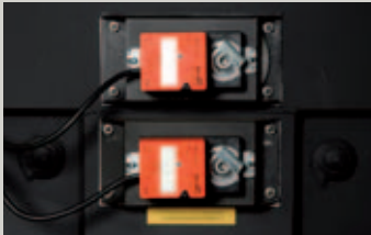
Unitate de reglare a aerului primar și secundar
